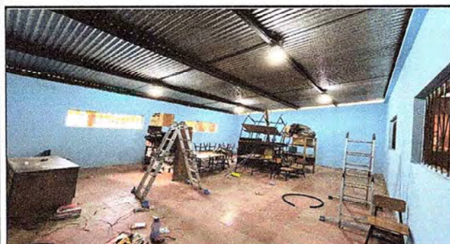
Foto 3: INSTALACIÓN ELÉCTRICA EN PROCESO
