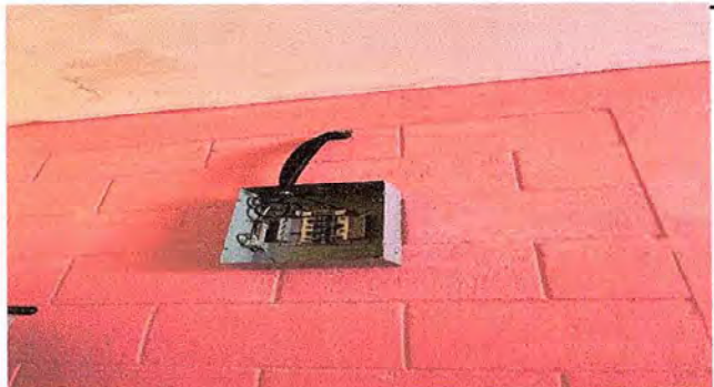
Foto 4: INSTALACIÓN DE CABLEADO
