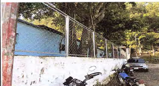
Foto 5: MALLA PERIMETRAL EN PROCESO DE CAMBIO.
