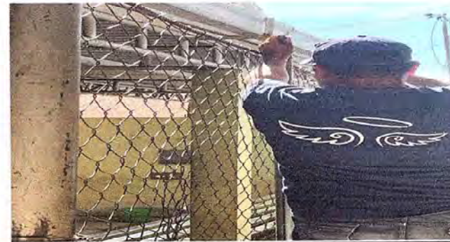
Foto 6: MALLA DE PUERTA PRINCIPAL EN REPARACIÓN.
