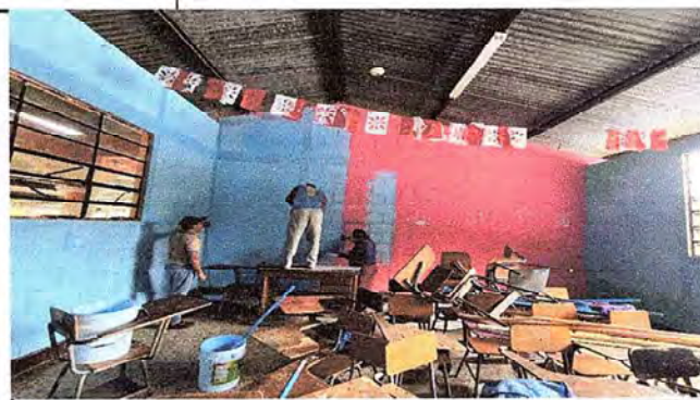
Foto 2: PINTURA EN AULAS DE TODO EL ESTABLECIMIENTO EN PROCESO DE PINTADO.
