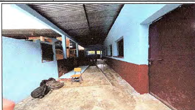
Foto1: PINTURA EN PAREDES DE LOS SANITARIOS EN PROCESO.
